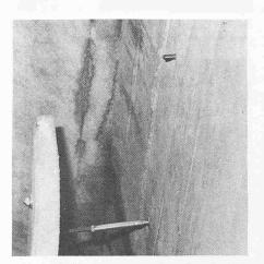
Bild 3. Verkleidungsplatten. Die Tunnelverkleidung aus vorfabrizierten Betonelementen wurde unten abgestellt und oben dann mit zwei speziellen Halteplatten und Klebeankern aus rostfreiem Stahl fi-
