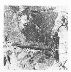
Mörtelanker, wie er vorwiegend in schlechtem, brüchigem Fels verwendet wird
