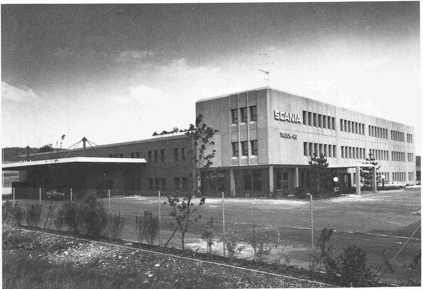
Ansicht von Südwesten. Links der Lagertrakt, rechts der Bürotrakt mit Haupteingang
