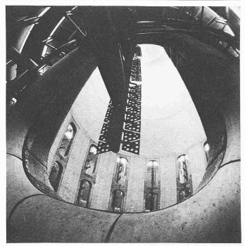
Blick in die Bodenfackel, in der die Flammen inerhalb eines Zylinders von 10 m Durchmesser und 27 m Höhe brennen und deshalb nicht direkt sichtbar sind; die Schallausbreitung ist ebenfalls erheblich gedämpft
