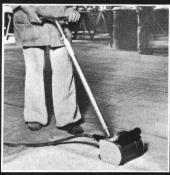
Zum Entfernen von Schmutz, Krusten, Rost, Farbschichten, Betonüberzähne und Markierungen.
