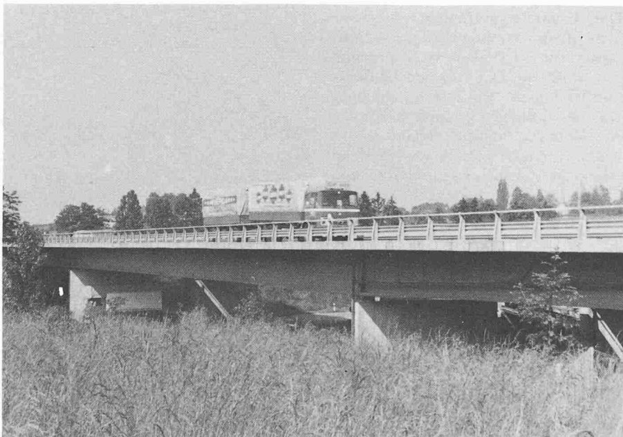
Bild 1. Pont de la Venoge, eine Verbundbrücke der Autobahn Lausanne-Genève N1, unter Verkehrslast. Siehe auch Bild 9
