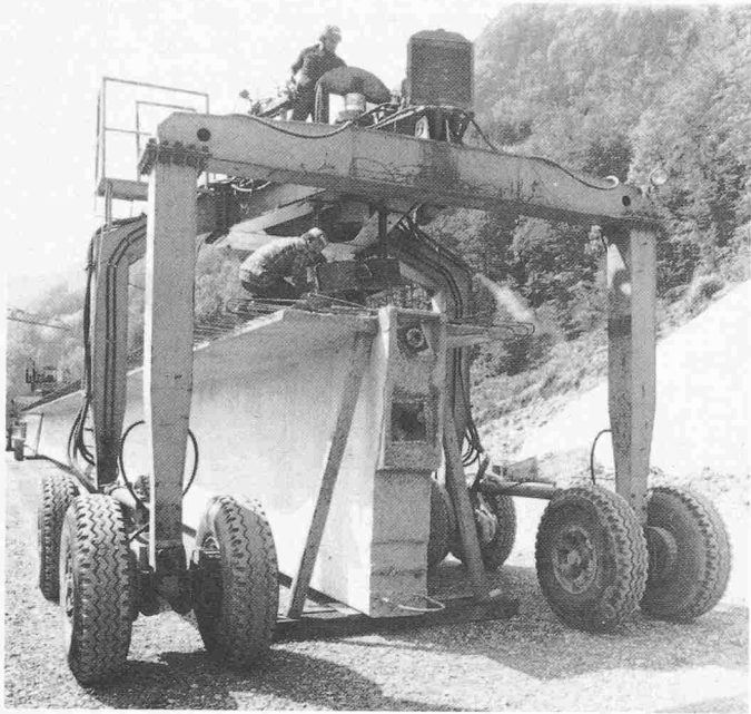
Bild 6. Transport eines rund 90 t schweren Trägers mit den «Elefanten»
