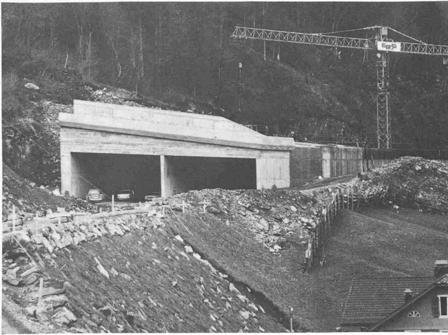
Bild 8. Die Galerie Fischlaui ist ein im Tagbau erstellter Tunnel, durch den das Normalprofil unverändert hindurchgeführt wird. Die talseitige Längswand wird gänzlich eingefüllt. Auf dem Galeriedach quert ein Waldweg den durch Leitwerke seitlich begrenzten Lawinenzug
