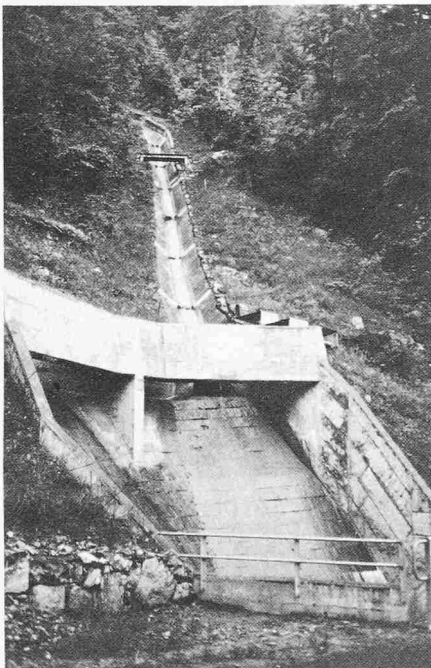
Bild 9. Chellbach. Ortbetongerinne mit hundertprozentigem Gefälle und Kiessammler
