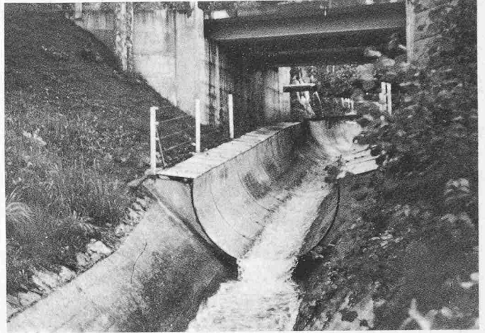
Bild 8. Mühlebach. Übergang Ortbetonschale zu Wellblechschale mit Werkstrassenbrücke
