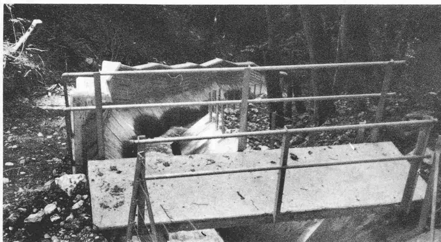
Bild 4. Moklisbach. Ortbetongerinne mit Prallwand in engem Radius. Im Vordergrund ein spezieller Wildübergang Chellbach.
