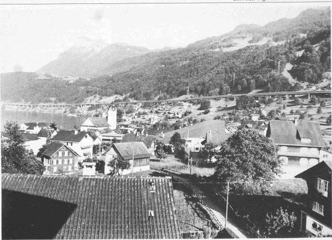
Auf einer Länge von 3148 Metern, gestützt auf 58 Pfeiler, zieht sich der Viadukt wie ein schmales Band über den topographisch und geologisch komplexen Hang zwischen Beckenried und dem Nordportal des Seelisbergtunnels
