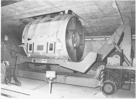
Bild 2. Einbau eines Ventilators
