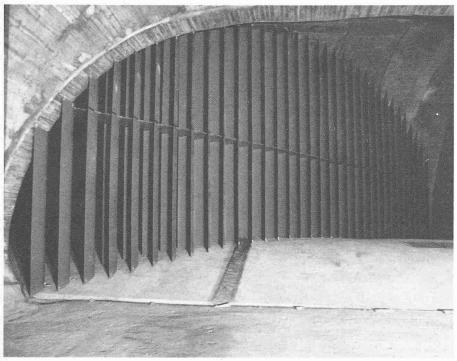
Bild 3. Umlenkgitter, eingebaut in einem Lüftungskanal
