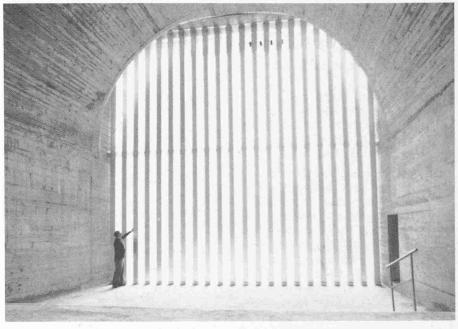
Bild 4. Schalldämpfer im eingebauten Zustand
