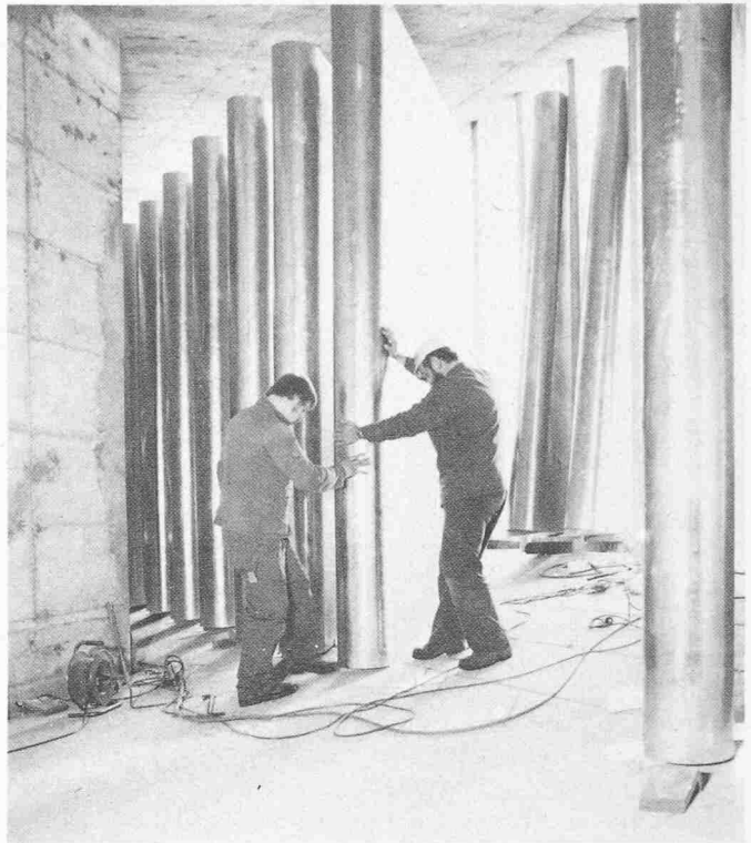
Bild 5. Montage der Kulissen-Schalldämpfer beim Abluftbauwerk Rütenen
