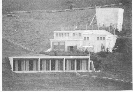
Bild 1. Lüftungsbauwerk Hattig mit Zuluftöffnung und Abluftkamin
