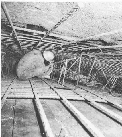
Bild 14. Scheitelarmierung des Innengewölbes Lüftungszentrale Huttegg
