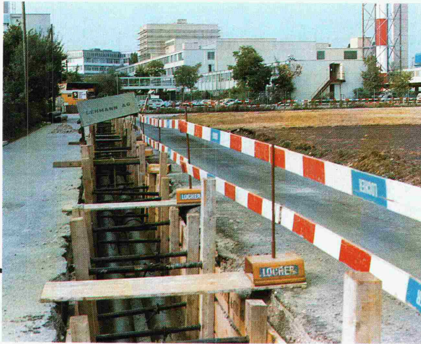
Anschluss Fernsehstudio DRS an Fernheizung Zürich / NW 200–355 mm
