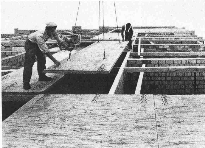
Versetzen einer PRELAM-Deckenplatte
