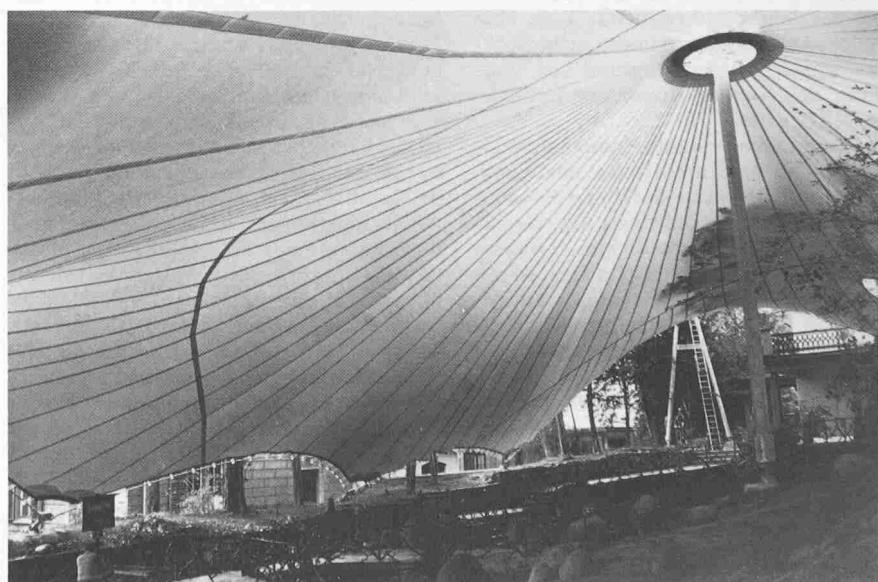
chung. Es handelt sich um eine Dachhaut von etwa 1000 m<sup>2</sup> aus transluzentem Sarnafil S, das aus einem hochfesten PES-Gittergewebe besteht, das mit PVC beschichtet ist. Die ganze Dachhaut wurde in Sarnen nach computerberechneten Schnittmusterplänen zugeschnitten und zu einem einzigen Stück verschweisst. Diese Haut wurde unter Schonung der verletzlichen Gletschermühlen (Sandstein) und des Baumbestandes am Zentralmast aufgerichtet, an den peripheren Ankerpunkten befestigt und gespannt.
