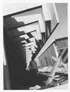
Perforiertes Vordach - Pergola - erzeugt einen natürlichen Luftdurchzug und dämmt die starke Lichtintensität. Die 2. Haut verhindert den direkten Sonnenstrahleinfall
