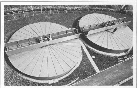
Kunststoffabdeckungen einer Abwasserreinigungsanlage (Durchmesser je 16 m)
