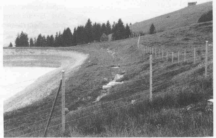
Bild 10. Ausgleichsbecken Gneida, Hangseite. Einige Jahre nach Inbetriebnahme. Die frühere Abrisskante der Rutschung liegt am rechten Bildrand. Auf der Berme in Bildmitte sind einzelne Brunnenschächte der Entlastungsbrunnen zu erkennen
