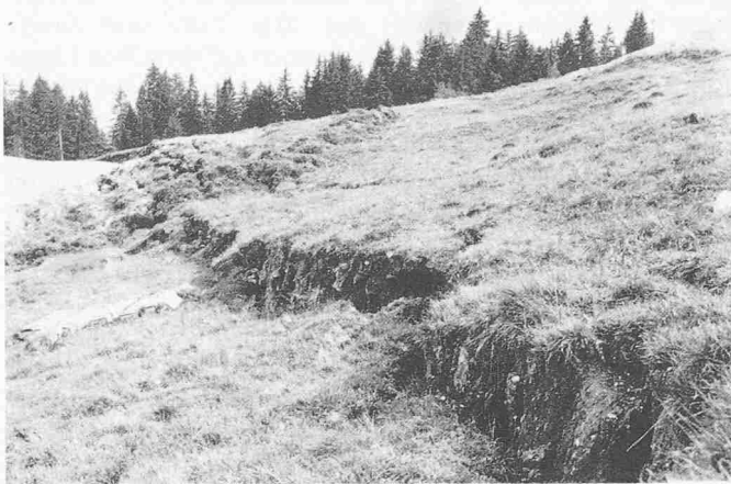
Bild 9. Ausgleichsbecken Gneida. Abrissrand der Rutschung. Man beachte das nahezu senkrechte Abtauchen der Gleitfläche
