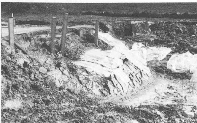
Bild 11. Baugrube Zürich, unmittelbar nach erfolgten Böschungsrutschungen. Man beachte das «Eintauchen» der Böschungsmasse in den Untergrund und die erhebliche rückwärtige Ausdehnung der Instabilität
