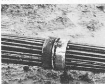
Bild 9. Fester Zwischenankerkopf des Spezialankers  $G_s$
