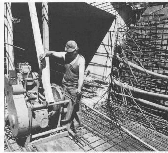
Seilwinde am Etappenanfang. Einziehen des Drahtbündels mit «Einziehstrumpf», mit Hilfe einer Umlenkrolle im Kasteninnern
