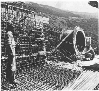
Vorderes Etappenende: Abziehgerät mit Drahtbündel 102 Ø7mm. Einziehen in die Hüllrohre vor dem Betonieren
