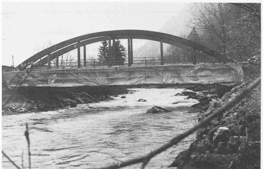
Bild 1. Gizenenbrücke mit untergehängtem Arbeitsgerüst
