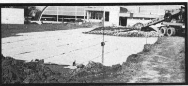
TREVIRA-spunbond wirkt als Trennschicht zwischen Untergrund und Drainagen, Dammschüttungen und Böschungen.
