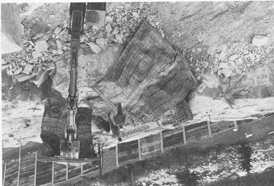
Bild 3. Abdeckung einer Sprengstelle
