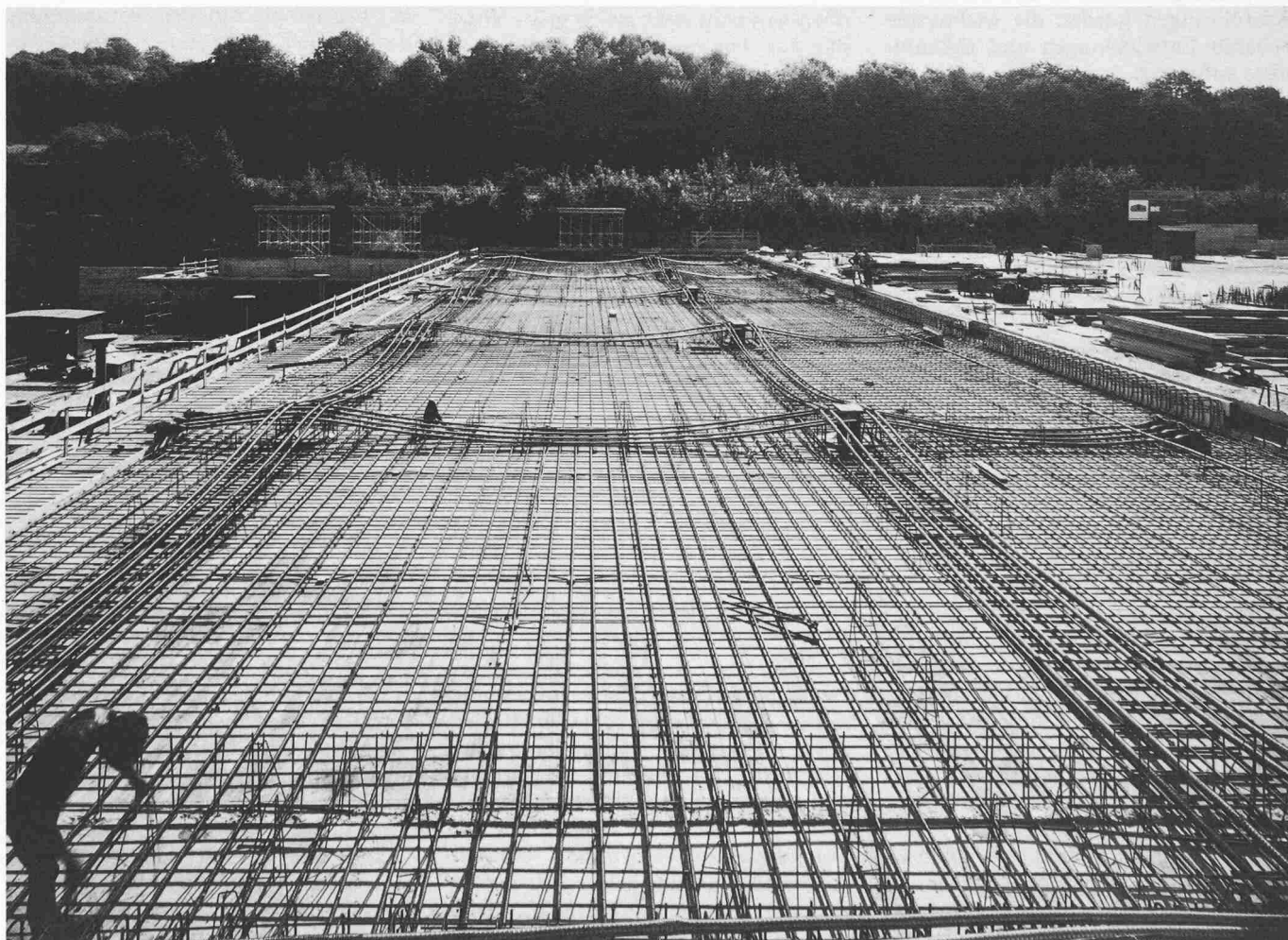
Bild 1. Stützstreifen-Vorspannung (obere Bewehrung noch nicht verlegt)
