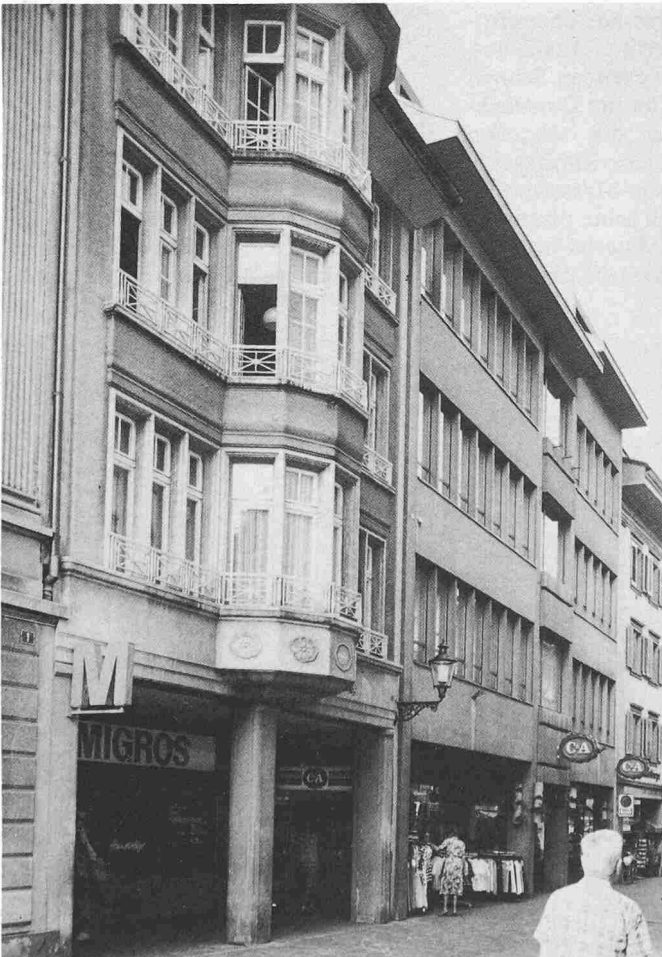
Geschäftshäuser an der Marktgasse von 1925 und 1965
