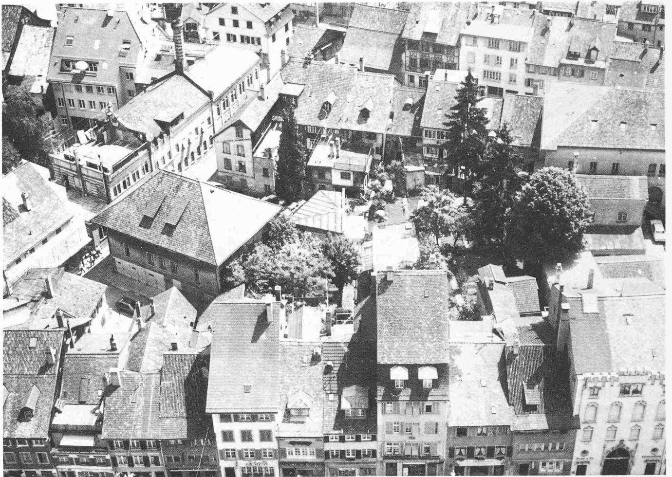
Die «Neustadt» mit Bürgerhäusern, Kornscheunen, Bad- und Waschanstalt von 1863 und Gärten
