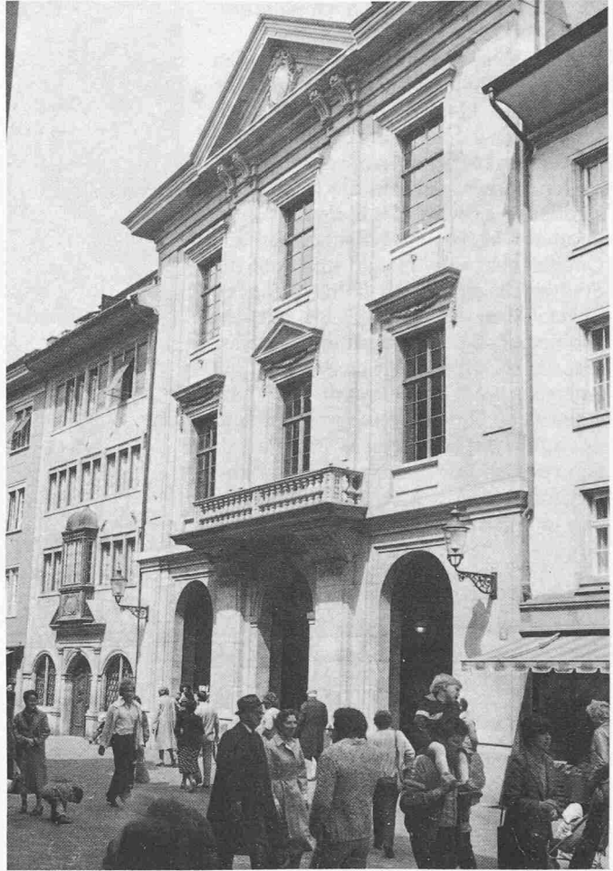
Das Rathaus, erwähnt 1423, Neubau 1784, Passage 1873, restauriert 1969
