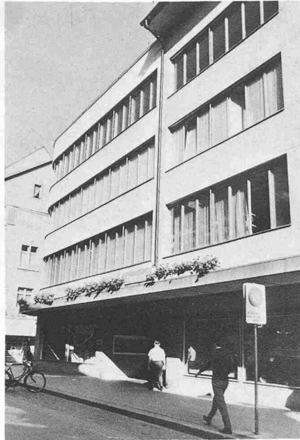
Geschäftshaus an der Marktgasse, 1934 erbaut von Zangerl, Streuli und Rüeegger
