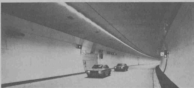
Transafe-Fühlerrohr (Kupferrohr von 5 mm Durchmesser, rechts vom Lichtband an der Tunneldecke)
