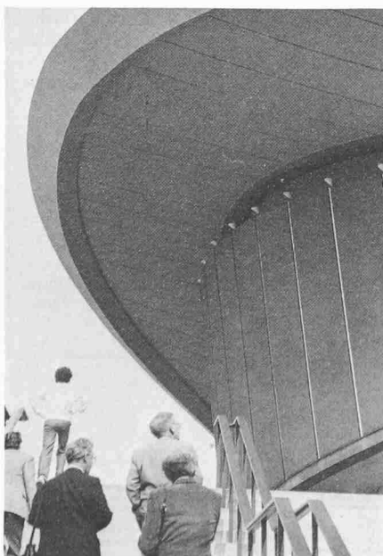
Nördliches Aussendach von der Westseite
