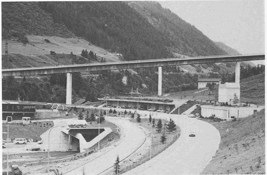
Bild 11. Blickrichtung quer zur Nationalstrasse Richtung Westen, mit dem Portal Airolo (links im Bild, dahinter ein Teil des Betriebsgebäudes) und in Bildmitte, bergwärts der neu angelegten Verbindungsstrasse Richtung Bedretto, die von aussen sichtbaren Teile der Lüftungszentrale Airolo. Das Frischluftfassungsbauwerk beschreibt einen langgezogenen Bogen, während sich die eigentliche Lüftungszentrale mit dem Abluftkamin, die über der Tunnelröhre liegt, sich rechts im Bilde befindet
