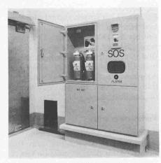
Bild 24. Alarmkasten in Schutzraum Figura 24 Armadio d'allarme in un rifugio
