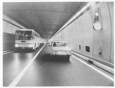
Signalampel mit Geschwindigkeitsanzeige im Tunnel Figura 22 Segnale luminoso di limitazione della velocità in galleria
