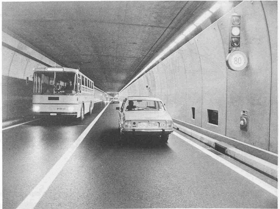
Bild 22. Signallampe mit Geschwindigkeitsanzeige im Tunnel Figura 22 Segnale luminoso di limitazione della velocità in galleria
