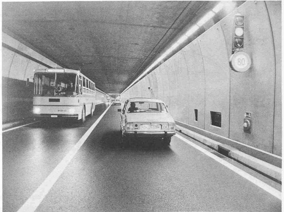
Bild 22. Signalampel mit Geschwindigkeitsanzeige im Tunnel Figura 22 Segnale luminoso di limitazione della velocità in galleria
