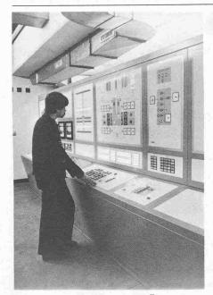
Bild 19. Zentrale Bedienungs- und Überwachungsstellen einer Lüftungszentrale
