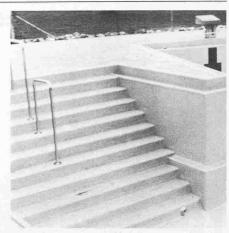
Auch die Treppen wurden mit dem KDB aus PVC ausgekleidet. Die Kunststoffdichtungsbahnen liegen auf der Betonunterlage lose auf. Auf den horizontalen Flächen wurde vorgängig ein Kunststofffaserfilz aufgelegt. Sämtliche begehbaren horizontalen Flächen mit Ausnahme des Schwimmbadbodens sind mit genoppten Kunststoff-Dichtungsbahnen belegt. Für Markierungen werden anders eingefärbte KDB-Streifen aufgeschweisst (schwarz, oben rechts)
