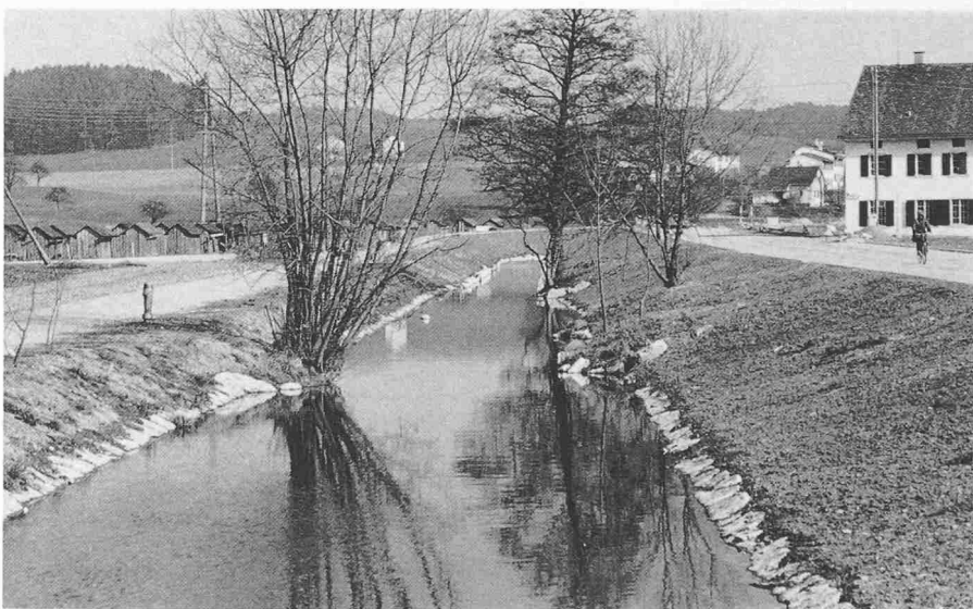
Bild 2. Eulach unterhalb Verzweigungsbauwerk. Links der neu gestaltete, entlastete Eulachlauf für Q = 15 \text{ m}^3/\text{s} im Staubereich des Wehres «Mühle Hegi». Unter der Umfahrungsstrasse (rechts) der Hochwasserkanal
