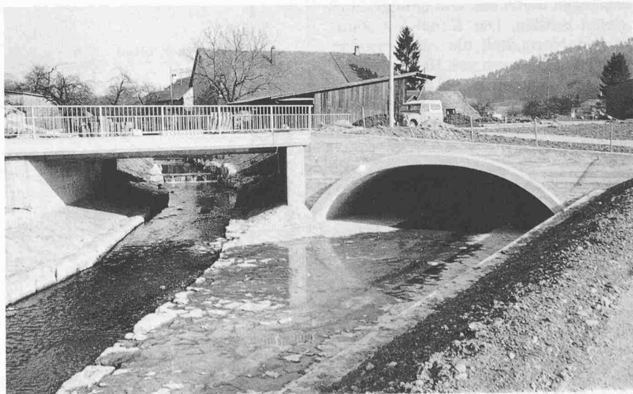
Bild 7. Vereinigungsbauwerk. Links: Bestehendes Eulachgerinne. Rechts: Auslauf der Hochwassereindolung
