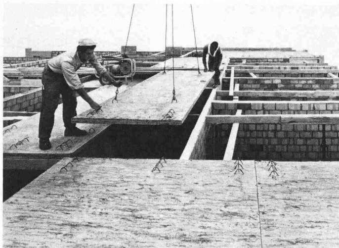
Versetzen einer PRELAM-Deckenplatte
