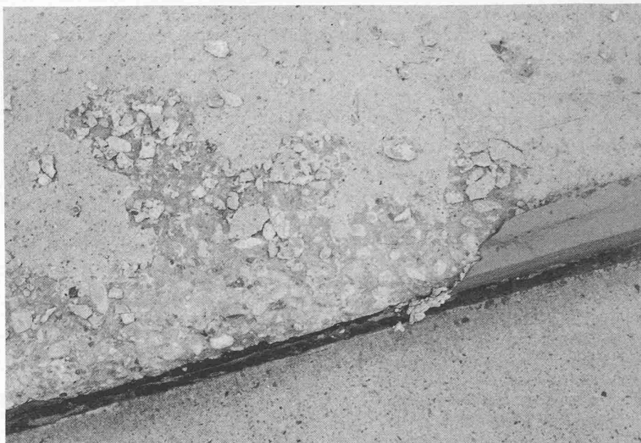
Bild 4. Durch Tausalz-Temperaturschock zerstörter Beton. Beachtenswert ist die unterschiedliche Betonart der Oberfläche und des Kernbetons. Die Beschichtung konnte die Zerstörung nicht verhindern
