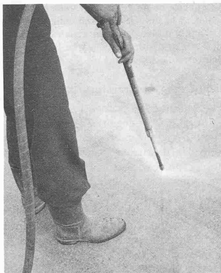
Bild 9. Reinigung der Betonoberfläche mit Hochdruckwasserstrahl (750 bar)
