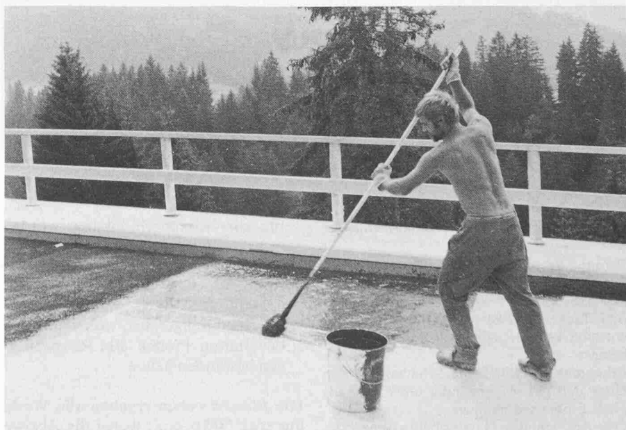
Bild 11. Auftragen der Abdichtung Efkaprene von Hand
