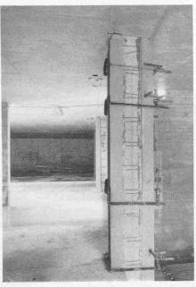
Bild 4. Kraftschlüssig verklebte Stahlwinkelprofile zur Erhöhung der Tragfähigkeit bei Ortbetonstützen
