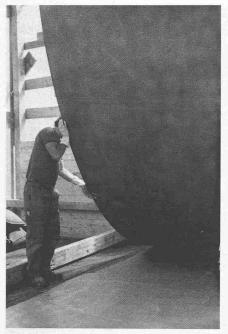
Bild 13. Aufkleben von 8 m² grossen Stahlblechen als Strahlenschutz für die Steuerorgane des Zonenpumpwerkes Hardhof in Zürich
