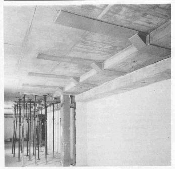
Bild 2. Die durch den nachträglichen Einbau einer Klimaanlage notwendig gewordenen Klebearmierung vor dem Ausfräsen der Deckendurchbrüche
