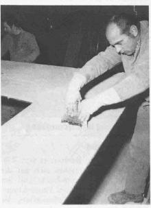
Bild 8. Auftragen von Klebemörtel mit dem Spachtel auf einen grossflächigen Flachstahlrahmen
