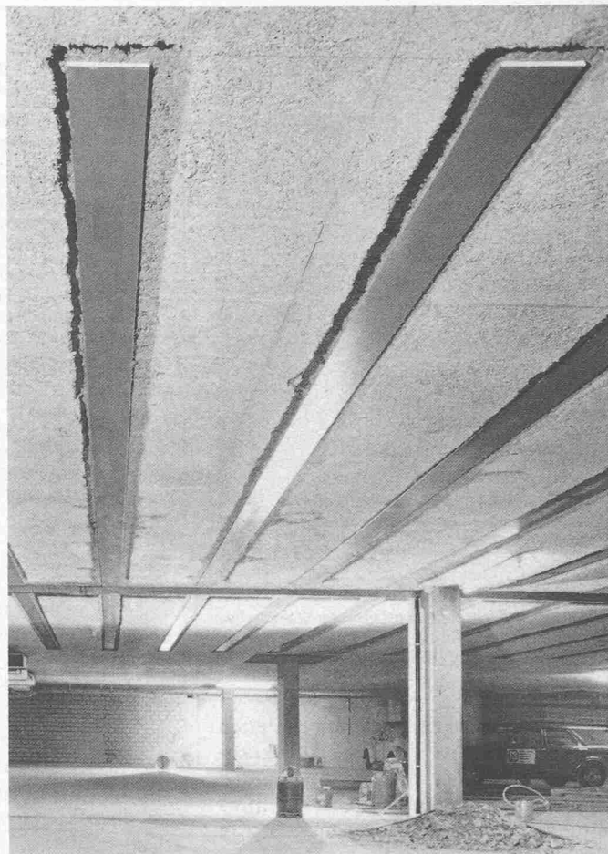
Bild 10. Verstärkung einer Flachdecke über einer Tiefgarage mit Klebarmierung. Zur Erhöhung der zulässigen Nutzlast wurde die Decke mit 216 Stahlblechen verstärkt
