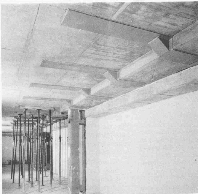
Bild 2. Die durch den nachträglichen Einbau einer Klimaanlage notwendig gewordenen Klebarmierung vor dem Ausfräsen der Deckendurchbrüche
