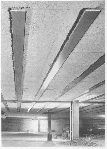
Bild 10. Verstärkung einer Flachdecke über einer Tiefgarage mit Klebearmierung. Zur Erhöhung der zulässigen Nutzlast wurde die Decke mit 216 Stahlblechen verstärkt
