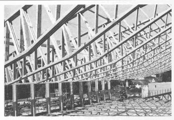
Eishalle Bülach: Ein Beispiel bei dem Menig-Nagelplatten als Verbindungsmittel verwendet wurden (Foto: LIGNUM/BO)
