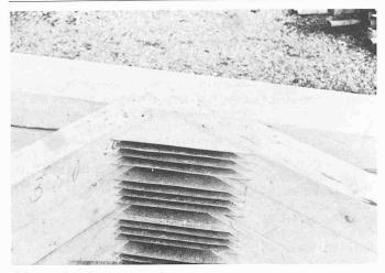
System Greim: In einteilige Stäbe, die eingefräste Schlitze aufweisen, werden Knotenbleche eingeschoben und durch Nagelung an die Hölzer angeschlossen (Foto: LIGNUM)
