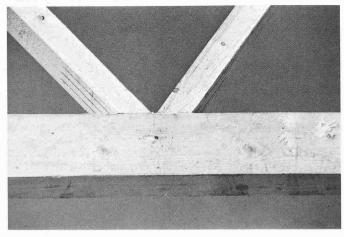
System Blumer: Jeder Anschluss ist beim «BSB» in seiner Ansicht genau zentrisch; die Kräfteübertragung erfolgt im Knotenzentrum; im Holz treten lediglich Kräfte in Faserrichtung auf (Foto: Blumer, Waldstatt)
