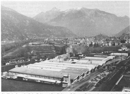
Die Werkanlagen der Forbo Giubiasco AG in Giubiasco. Früher war Giubiasco das einzige Linoleum-Werk der Schweiz, heute werden in diesen ausgedehnten Werkhallen auf einer 300 m langen Anlage strukturierte, mit transparenter PVC geschützte und mit Schaumrücken auf der Unterseite ausgerüstete Cushioned-Vinylbeläge (Novilon) hergestellt
