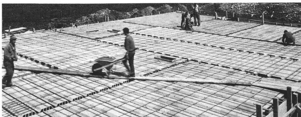
**PRENORM – die schalungsfreien Decken mit Deckensteinen aus gebranntem Ton und Betonbalken mit oder ohne Tonschuh.**
