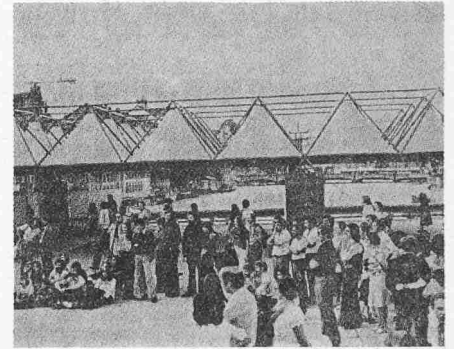
Eine Konstruktion für viele Funktionen: ein Dach für geplante und ungeplante Aktivitäten. Rathausbrücke Zürich, 1973
