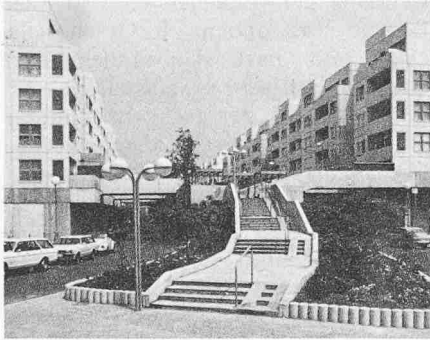
Teilweise Überdeckung von Strasse und Autoabstellplätzen durch Spiel- und Grünflächen. Sonnenallee, Berlin-Neukölln, 1977
