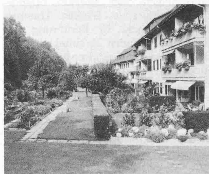
Kombination von Gartenfunktionen. Rechts Erdgeschosswohnungen mit Privatgärten, links Schrebergärten, dazwischen Wiese. Mehrfamilienhäuser, BS
