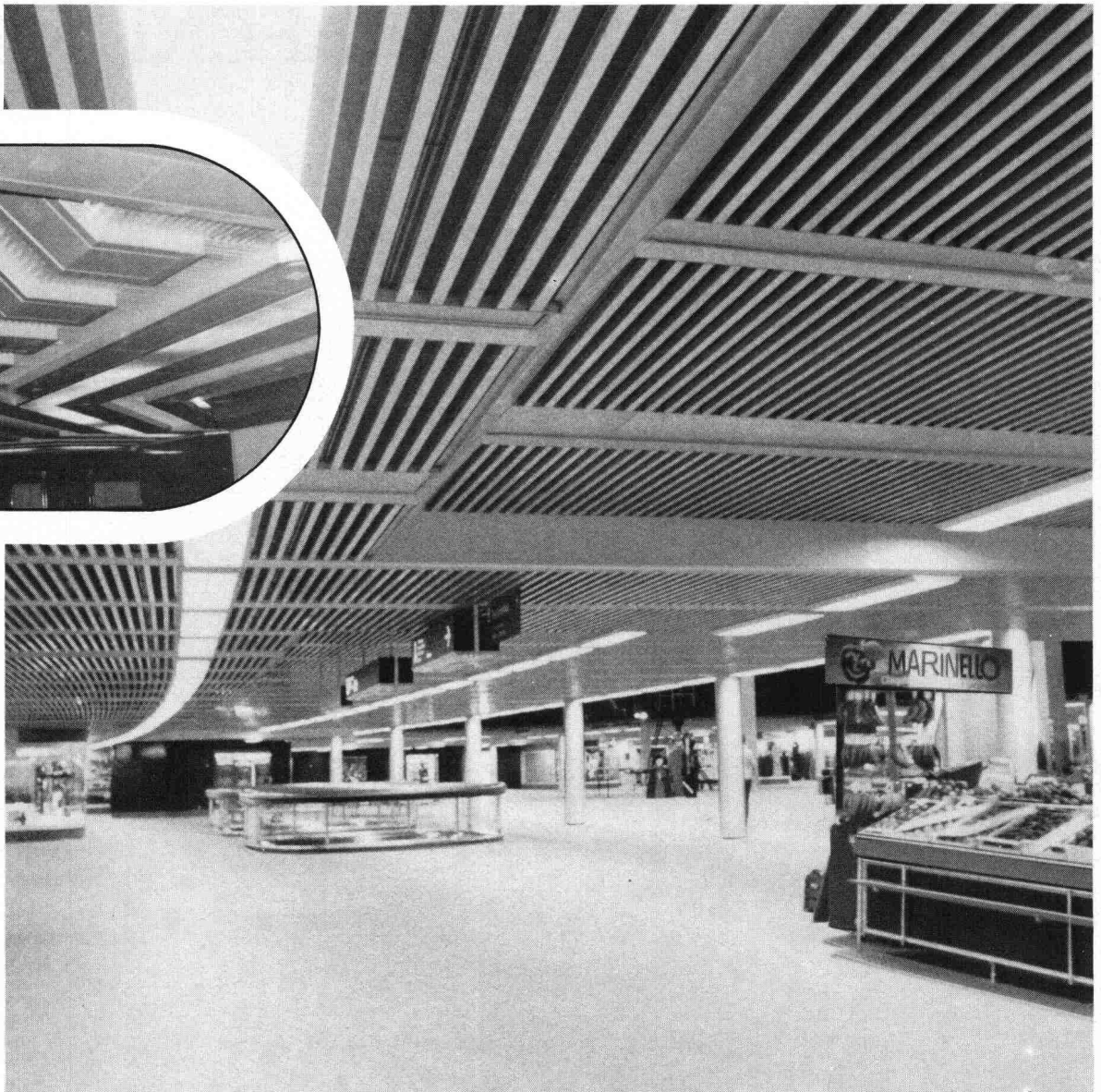
Fotos: Parkhaus B, Ladenstrasse Geschoss 2
