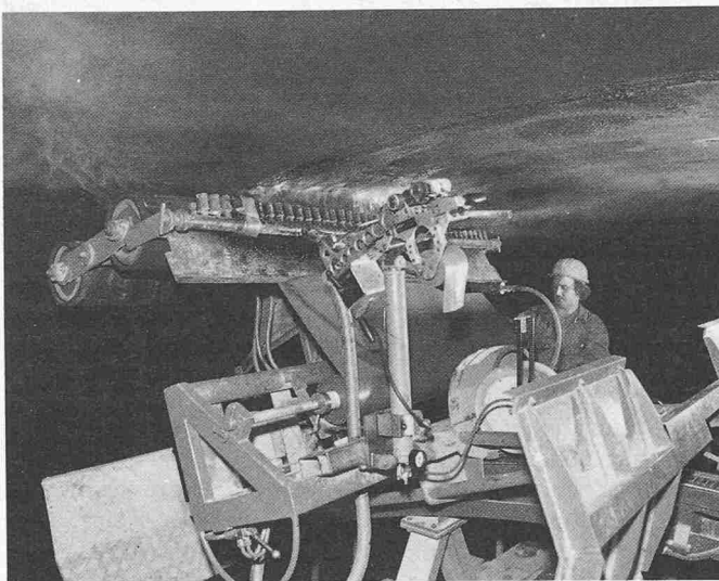
Bild 5. Los West. Aufkleben der Gewölbeisolation auf das Aussengewölbe
