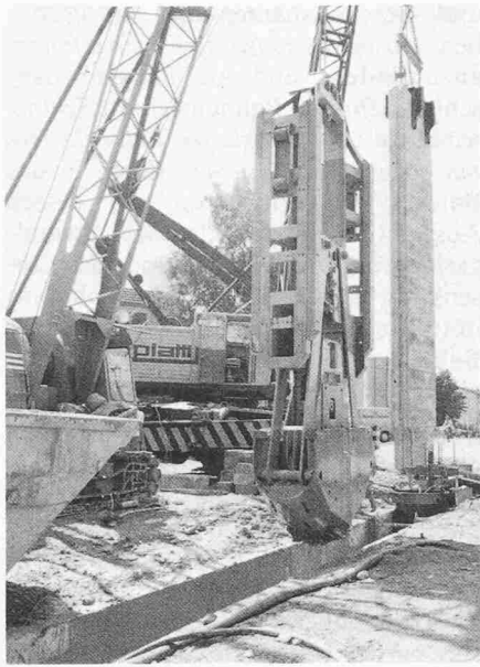
Bild 2. Schlitzaushub und Versetzen eines vorfabrizierten Wandelements
