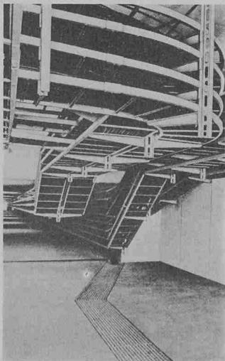
Kabelführung wird durch Steigetrassen in 600 mm Sprossenabstand ermöglicht, die so ausgelegt sind, dass handelsübliche Schellen passen. Zwei Typen für Wandverlegung und eine Type für freistehende Anordnung gewährleisten, dass alle in der Praxis auftretenden Fälle beherrscht werden. Sonderkabelpritschen für spezielle Einsatzzwecke, z.B. für grosse Stützweiten bis zu 10 m sind ebenfalls im Programm enthalten.
