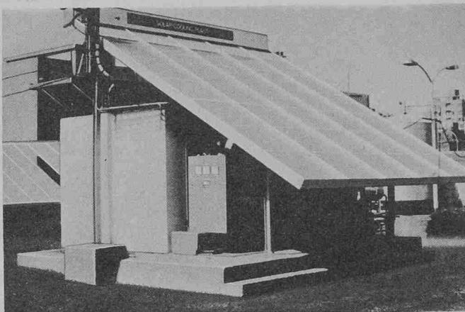
eine Kühlzelle, in der Nahrungsmittel durch Sonnenenergie auf Kühlzschrank-Temperatur gekühlt werden. Hierzu dient eine
