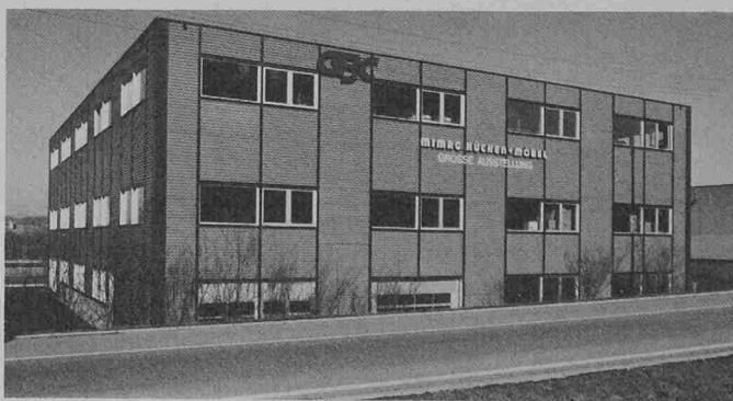
die äußerst attraktive Arcoy-Alufassade und doppelverglaste Fenster mit zweifach gebrochenem Rahmen, um Kältebrücken zu vermeiden. Diese Fassade wurde an Ort und Stelle mit dem Startex-Spritzdämmstoff in 14 cm Dicke nahtlos gefüllt. Das Dach in Stahl-Holz-Konstruktion (siehe Bild) erhielt eine 20 cm starke Isolation mit Star-
