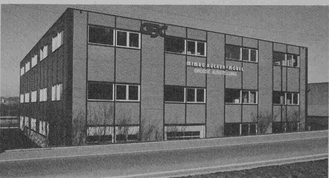
die äusserst attraktive Arcoy-Alufassade und doppelverglaste Fenster mit zweifach gebrochenem Rahmen, um Kältebrücken zu vermeiden. Diese Fassade wurde an Ort und Stelle mit dem Startex-Spritzdämmstoff in 14 cm Dicke nahtlos gefüllt. Das Dach in Stahl-Holz-Konstruktion (siehe Bild) erhielt eine 20 cm starke Isolation mit Star-
