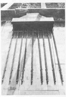
Bild 4. Stahlverstärkung, auf die Schalung verlegt
