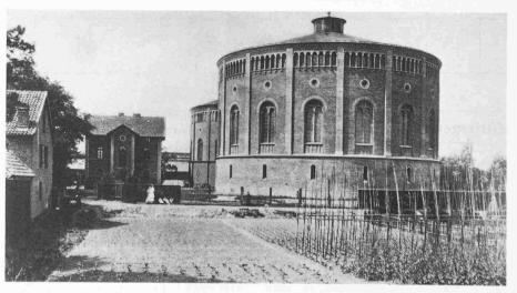
In den siebziger Jahren des vergangenen Jahrhunderts wurden die Verkleidungen für zwei grosse Gasspeicher gebaut, die, je nach Füllungsgrad, aus einem 12 m tiefen Wasserbecken bis auf die doppelte Höhe über den Boden gehoben wurden
