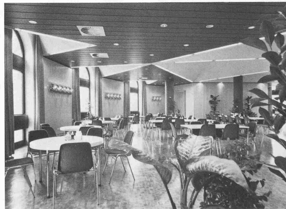
Blick in die Kantine im obersten Geschoss des Gasbehälters
