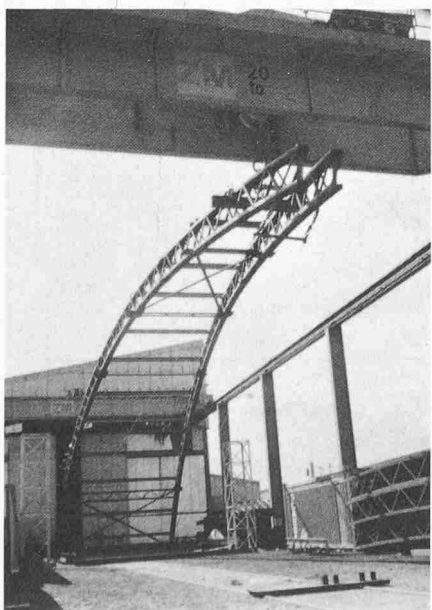
Bild 6. Probemontage
