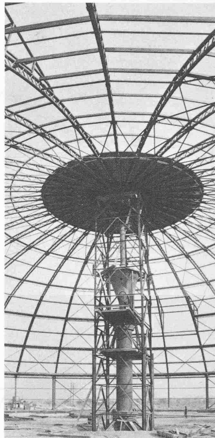
Bild 8. Montage mit Hilfe des Turms
