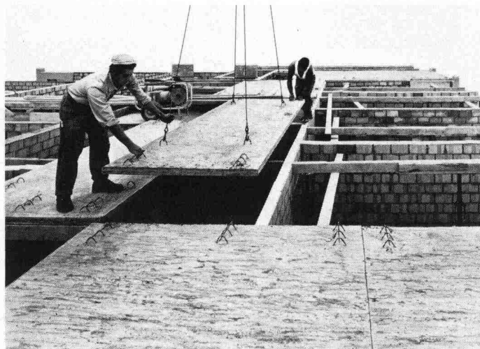
Versetzen einer PRELAM-Deckenplatte
