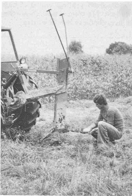
Bild 7. Maulwurfdrainage mit Traktor als Zugmaschine
