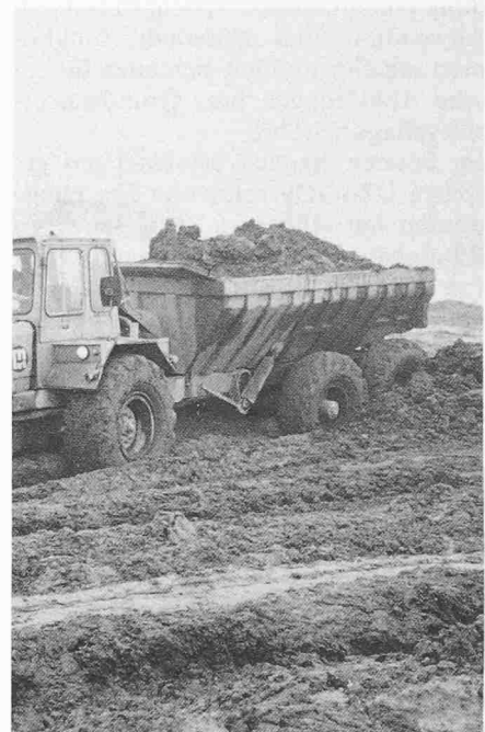
Bild 1. Auffüllarbeiten bei nassem Wetter
