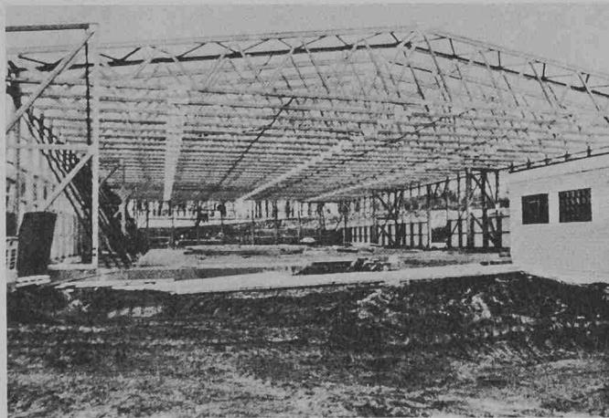
Doppeltrapezbindern mit einseitigem Kragarm, 2 m Mittenabstand und einer Gesamtspannweite von 36,24 m (einschliesslich des Vordaches auf einer Seite). Die freie Spannweite innen beträgt 29,32 m.
